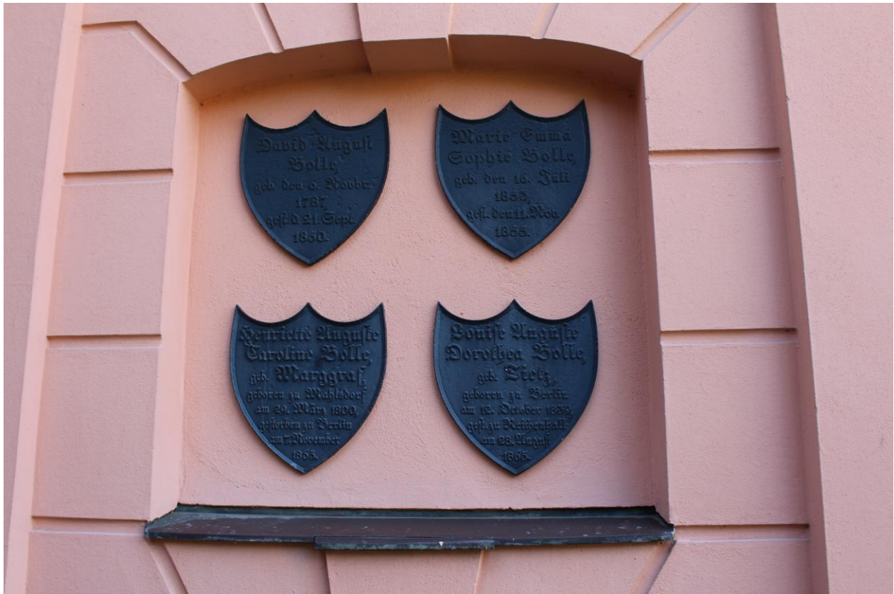
Familie Bolle (ab 1850), vier wappenförmige Metalltafeln an der Nordwand der Kirche
