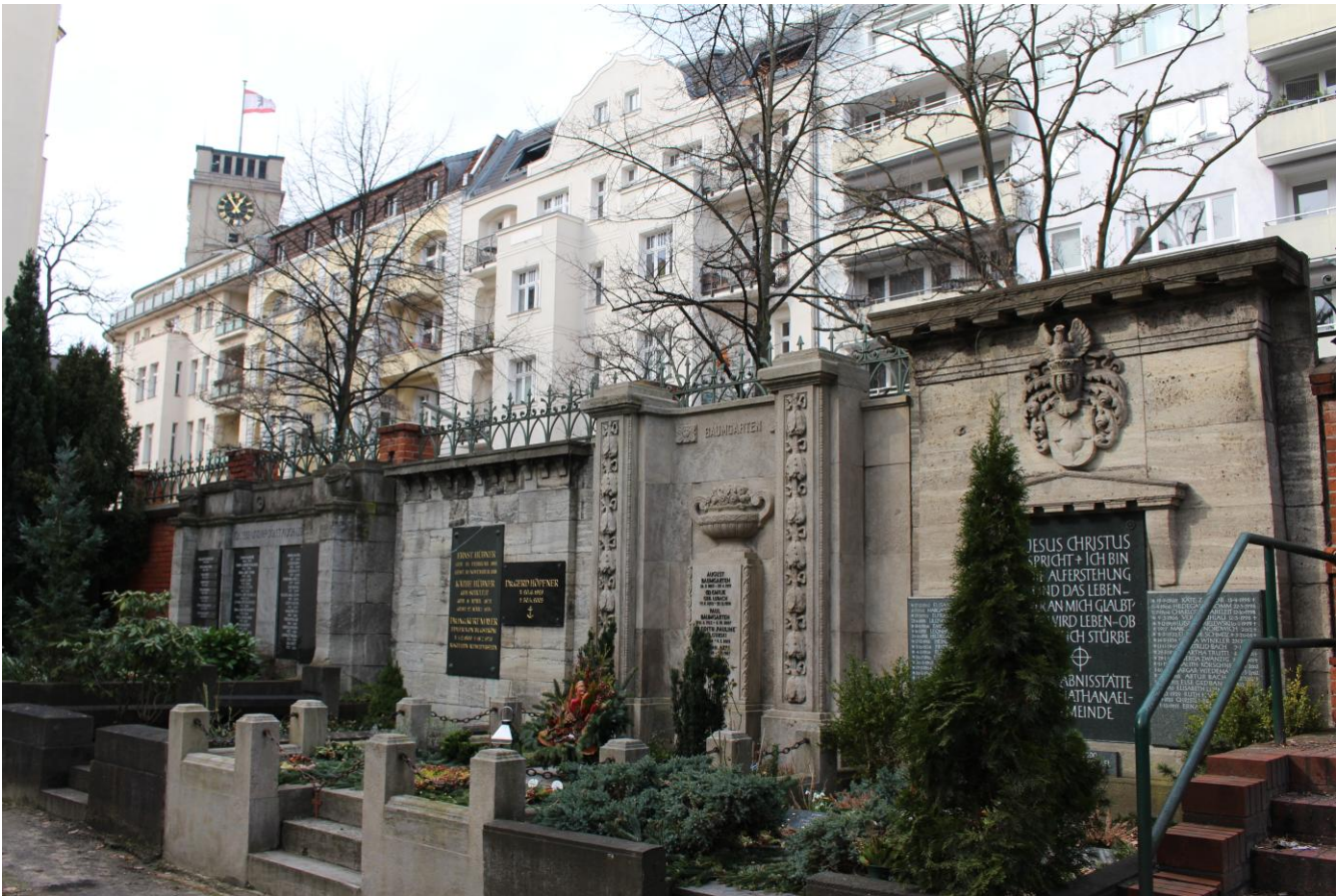
Gemeinschaftsanlagen an der Nordwand (Belziger Straße, links oben Schöneberger Rathausurm)
